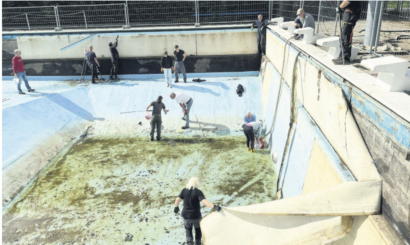
Der Startschuss für die Modernisierung des Bodenburger Freibades ist erfolgt. Etwa 35 Personen beteiligten sich an dem ersten Arbeitseinsatz. Im Mittelpunkt standen das Entfernen der Folie an den Seiten des Schwimmerbeckens. FOTO: VOLLMER
